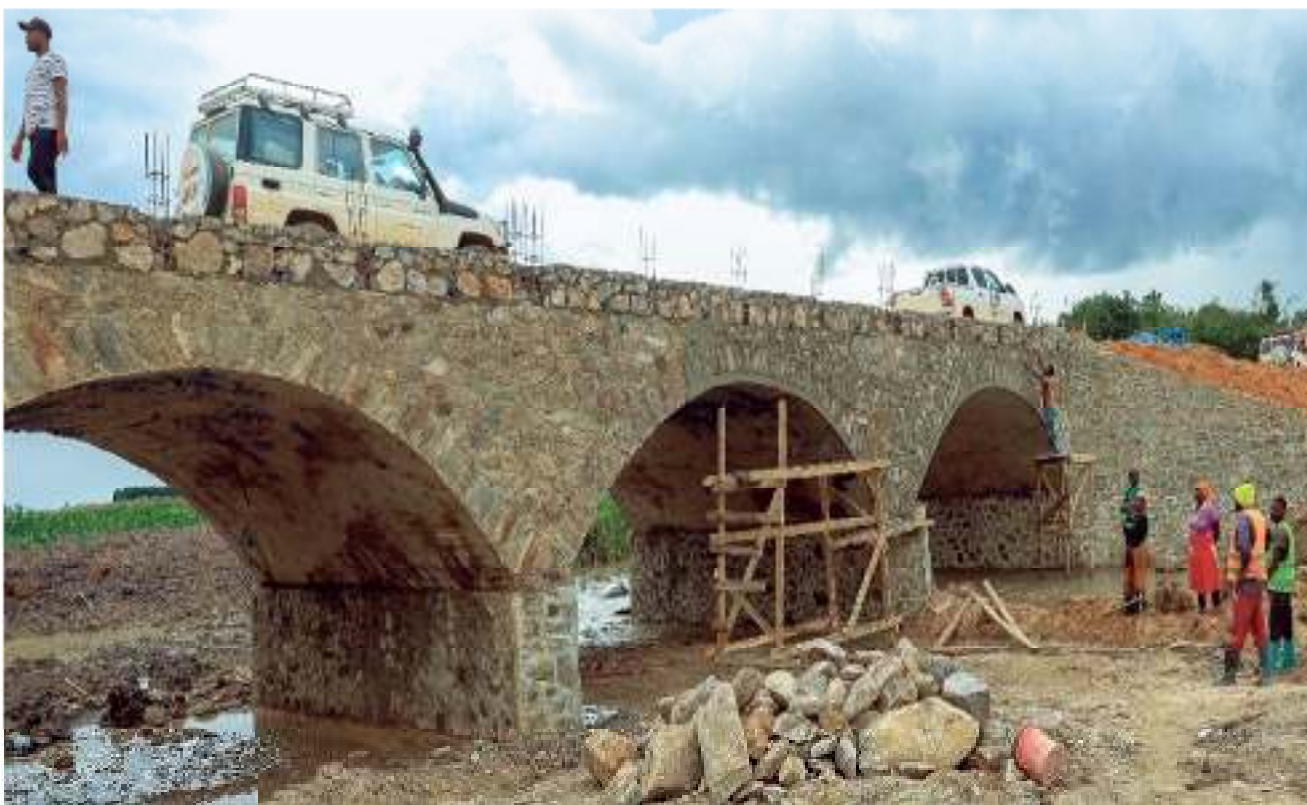
Picha inayoonesha ujenzi wa daraja katika barabara ya Ifunda – Bandabichi katika Halmashauri ya Wilaya ya Iringa
