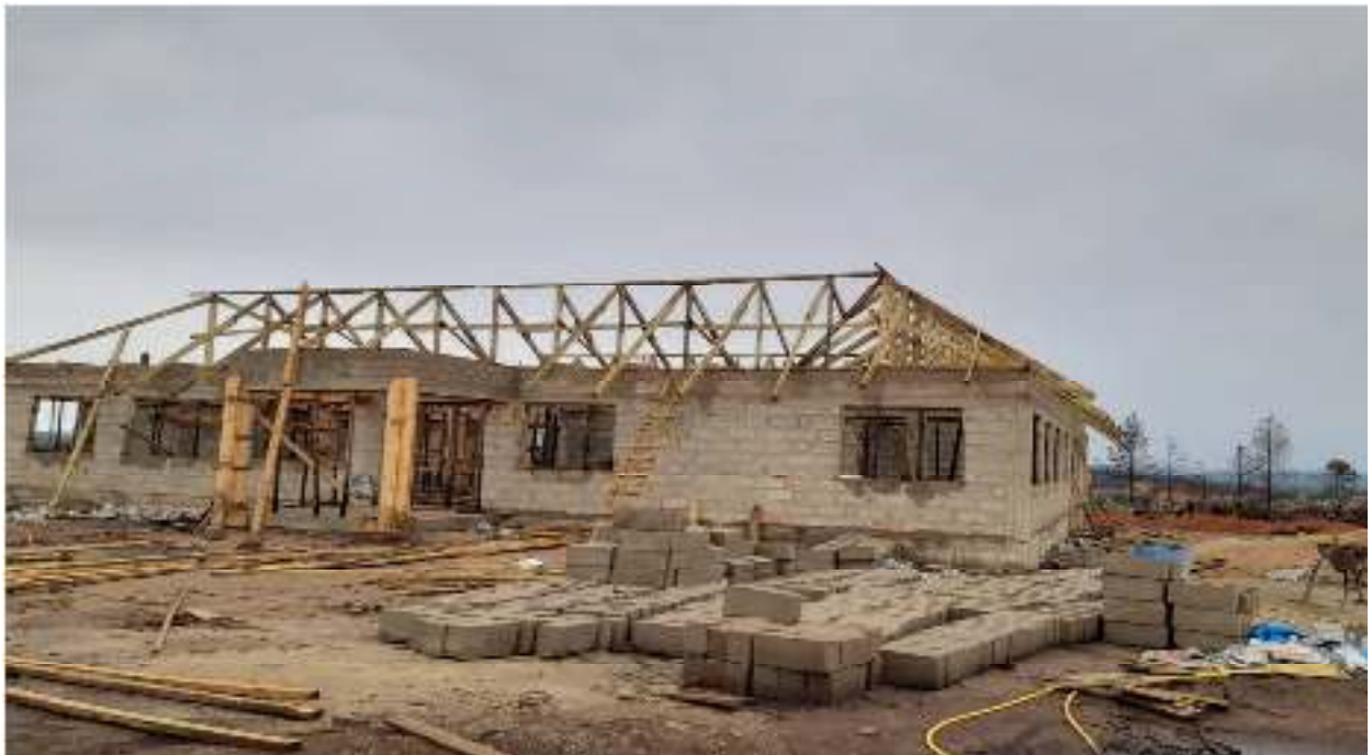
Picha inayoonesha hatua iliyofikiwa katika Ujenzi wa jengo la wagonjwa wa nje Kituo cha Afya Kibengu, Halmashauri ya wilaya Mufindi.
