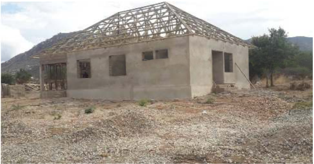
Picha inayoonesha ujenzi unaoendelea wa jengo la Maabara katika Kituo cha Afya Nyalumbu, Halmashauri ya Wilaya ya Kilolo.
