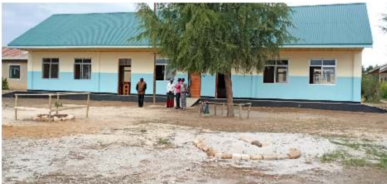
Picha inayoonesha jengo lenye madarasa mawili (2) na Ofisi ya Walimu katika Shule ya Sekondari ya Kinyanambo katika Halmashauri ya Mji Mafinga.
