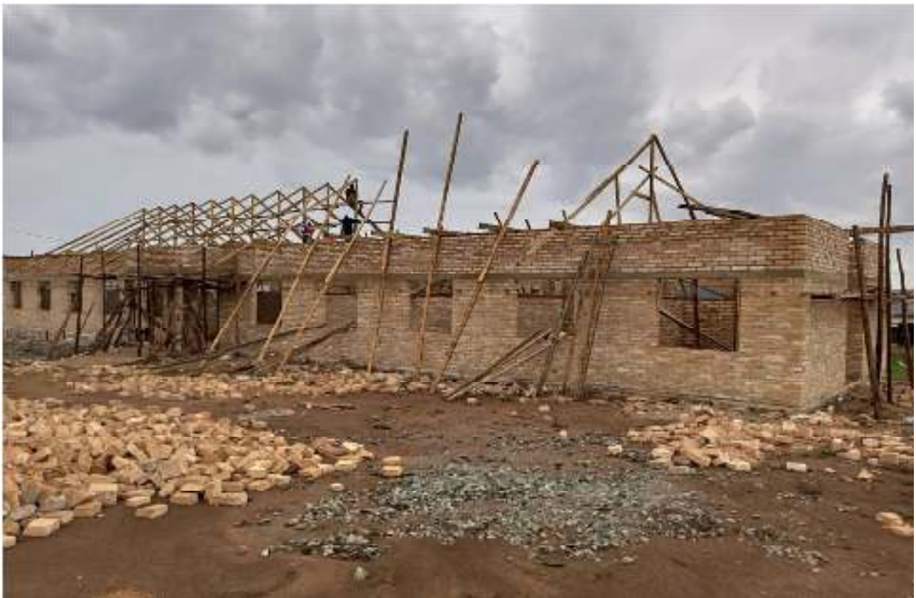
Picha inayoonesha jengo la bweni la wanafunzi wa Elimu Maalumu linaloendelea kujengwa katika Shule ya Msingi Amani, Halmashauri ya Mji Mafinga,
