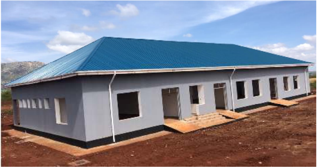
Picha inayoonesha ujenzi unaoendelea wa Jengo la muda la abiria (Terminal Building) katika uwanja wa Ndege wa Iringa..
