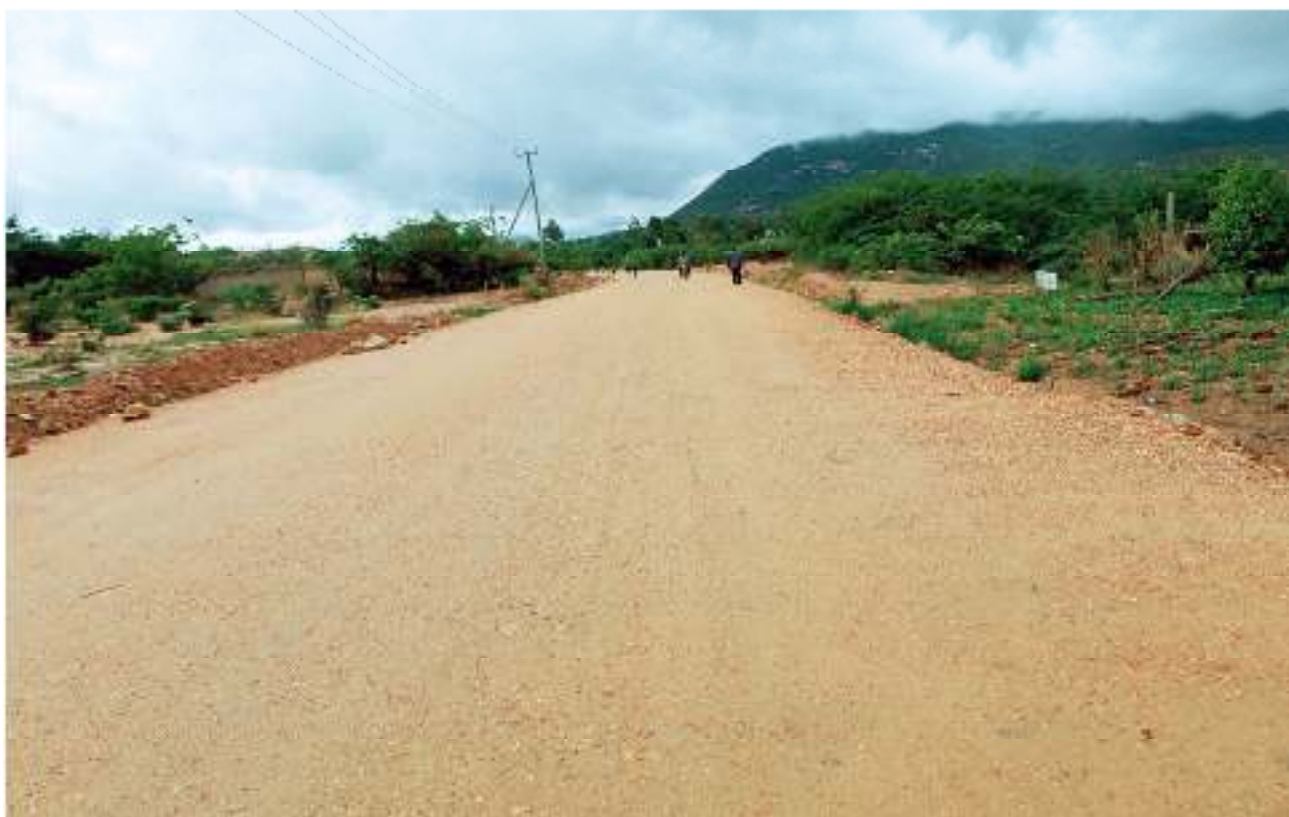
Picha inayoonesha ujenzi unaoendelea katika Barabara ya Donbosco-Mawelewele-Zizi (Manispaa ya Iringa)
