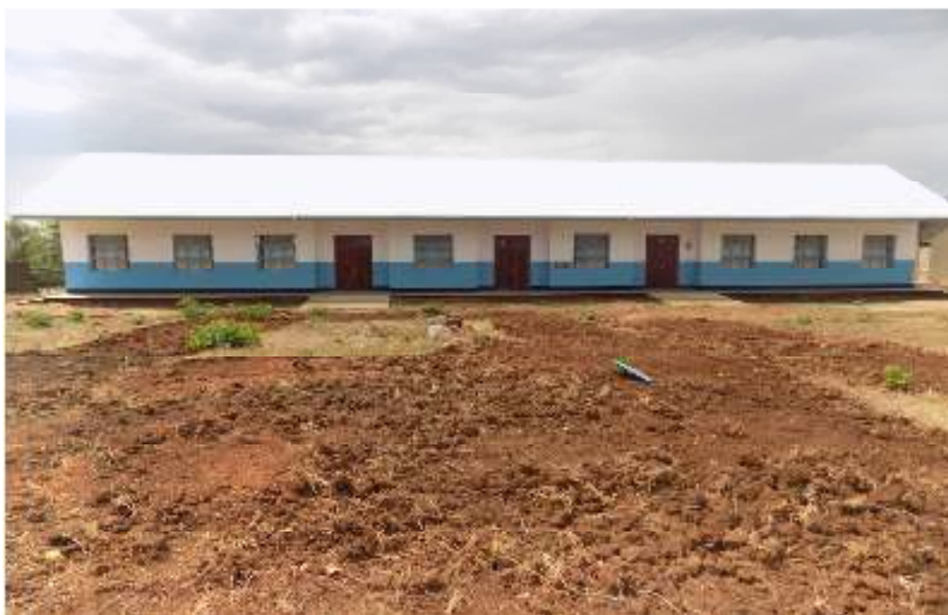
Picha inayoonesha jengo la Maabara katika Shule ya Sekondari ya Itengule iliyopo Halmashauri ya Wilaya ya Mufindi.
