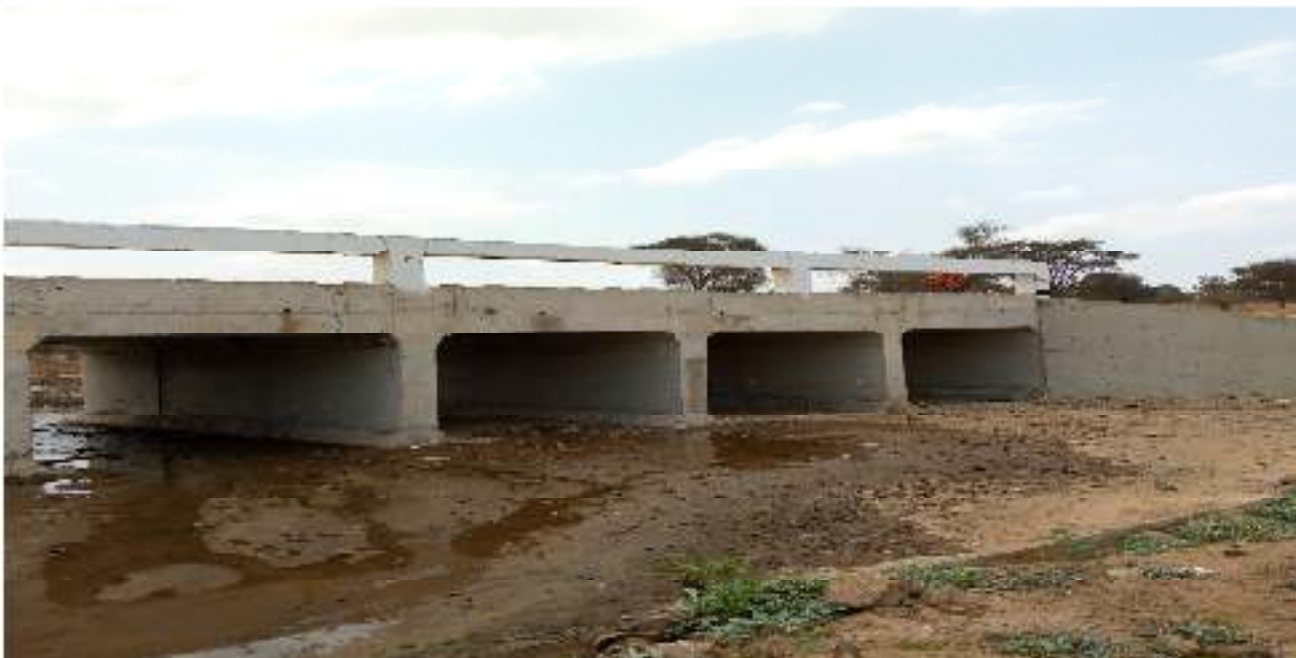
Picha inayoonesha ujenzi wa daraja box kalvati la midomo minne katika barabara ya Ilula – Ilambo (Halmashauri ya Wilaya ya Kilolo)
