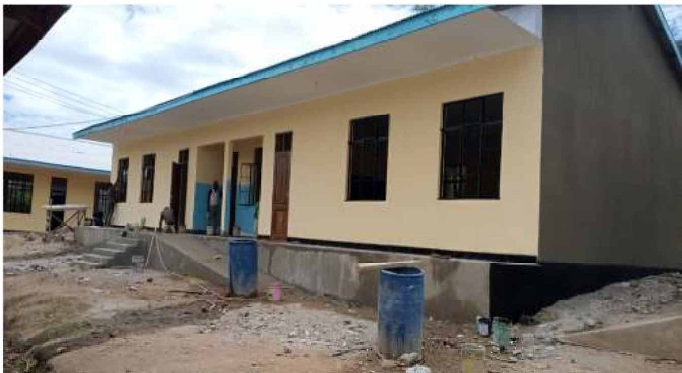
Picha inayoonesha jengo lenye Vyumba viwili (2) vya madarasa katika Shule ya Sekondari ya Tagamenda katika Halmashauri ya Manispaa ya Iringa
