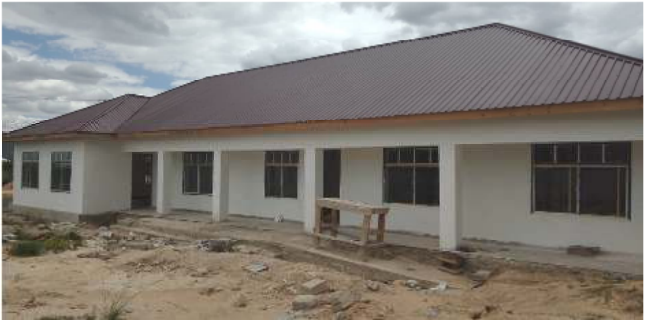
Picha inayoonesha ujenzi unaoendelea wa Jengo la Utawala katika Machinjio ya Kisasa ya Ngelewala iliyopo Halmashauri ya Manispaa ya Iringa.
