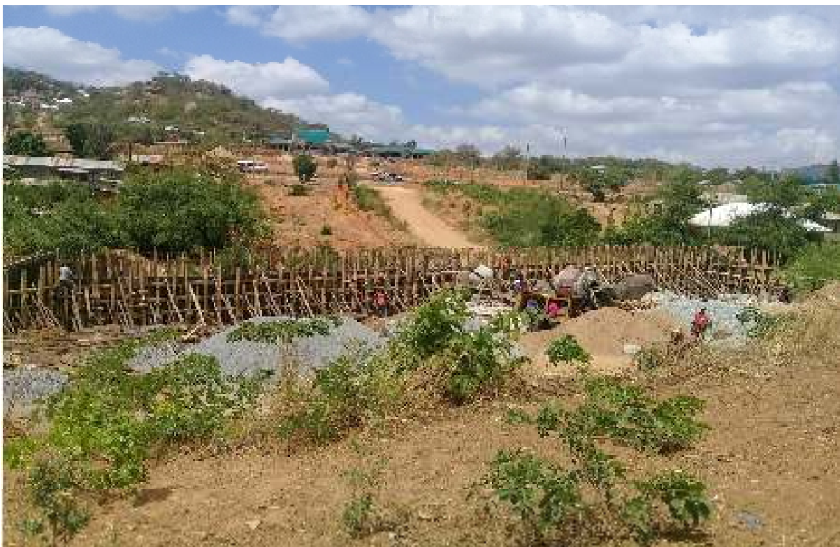
Picha inayoonesha Ujenzi wa daraja katika barabara ya mchepuo ya Kihesa Kilolo-Tumaini-Igumbilo eneo la Chuo kikuu cha Iringa katika Halmashauri ya Manispaa ya Iringa.
