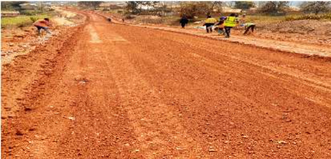
Picha inayoonesha uchanganyaji wa Chokaa kwenye barabara ya kidabaga – Bomalang’ombe iliyopo Halmashauri ya Wilaya ya Kilolo
