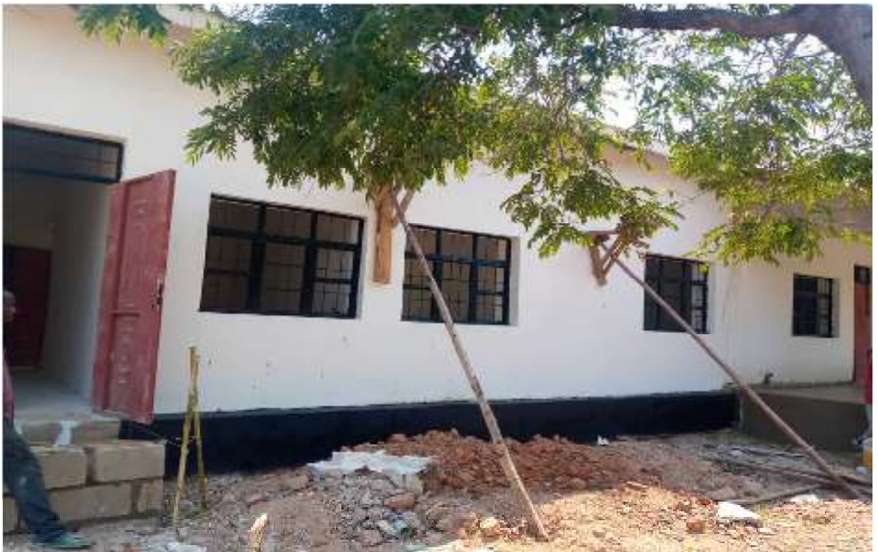
Picha ikionesha jengo la OPD la Zahanati ya Mtalagala likiwa limekamilika kwa asilimia 95, Manispaa ya Iringa.
