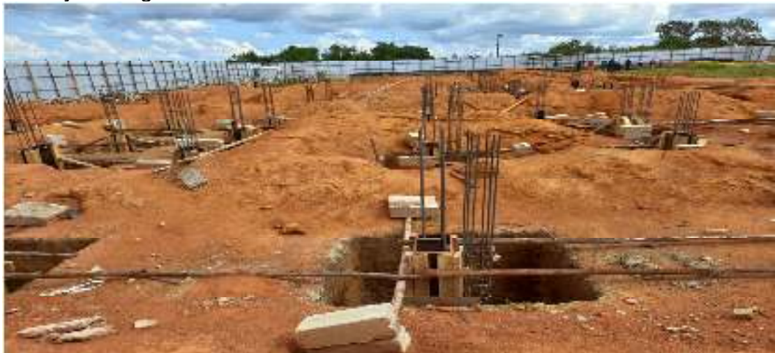
Picha inayoonesha ujenzi unaoendelea wa jengo la Utawala la Halmashauri ya Wilaya ya Mufindi.
