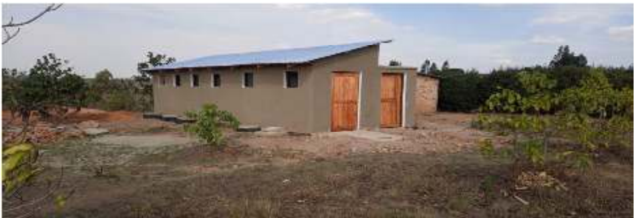
Picha inayoonesha Jengo la Choo katika Shule ya Sekondari ya Bumilayinga, iliyopo Halmashauri ya Mji Mafinga.
