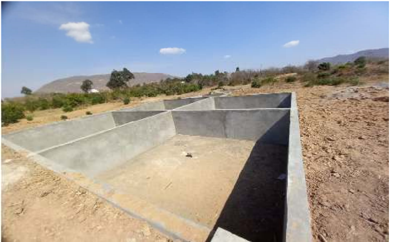
Picha inayoonesha ujenzi unaoendelea wa Mabwawa ya maji machafu katika Machinjio ya Kisasa ya Ngelewala iliyopo Halmashauri ya Manispaa ya Iringa
