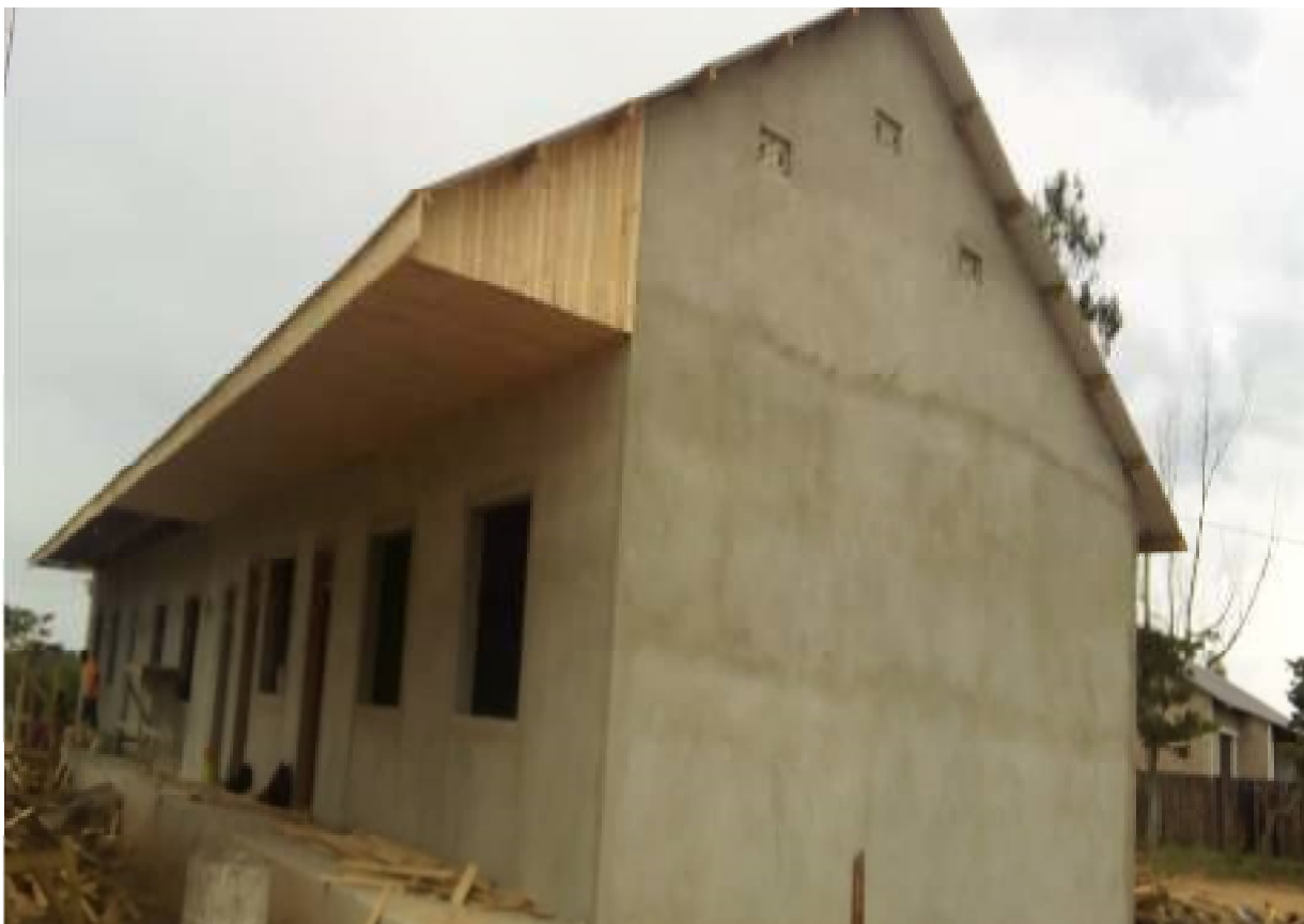
Picha inayoonesha kazi ya Umaliziaji wa ujenzi wa Madarasa Shule ya Sekondari ya Changarawe iliyopo Halmashauri ya Mji Mafinga.
