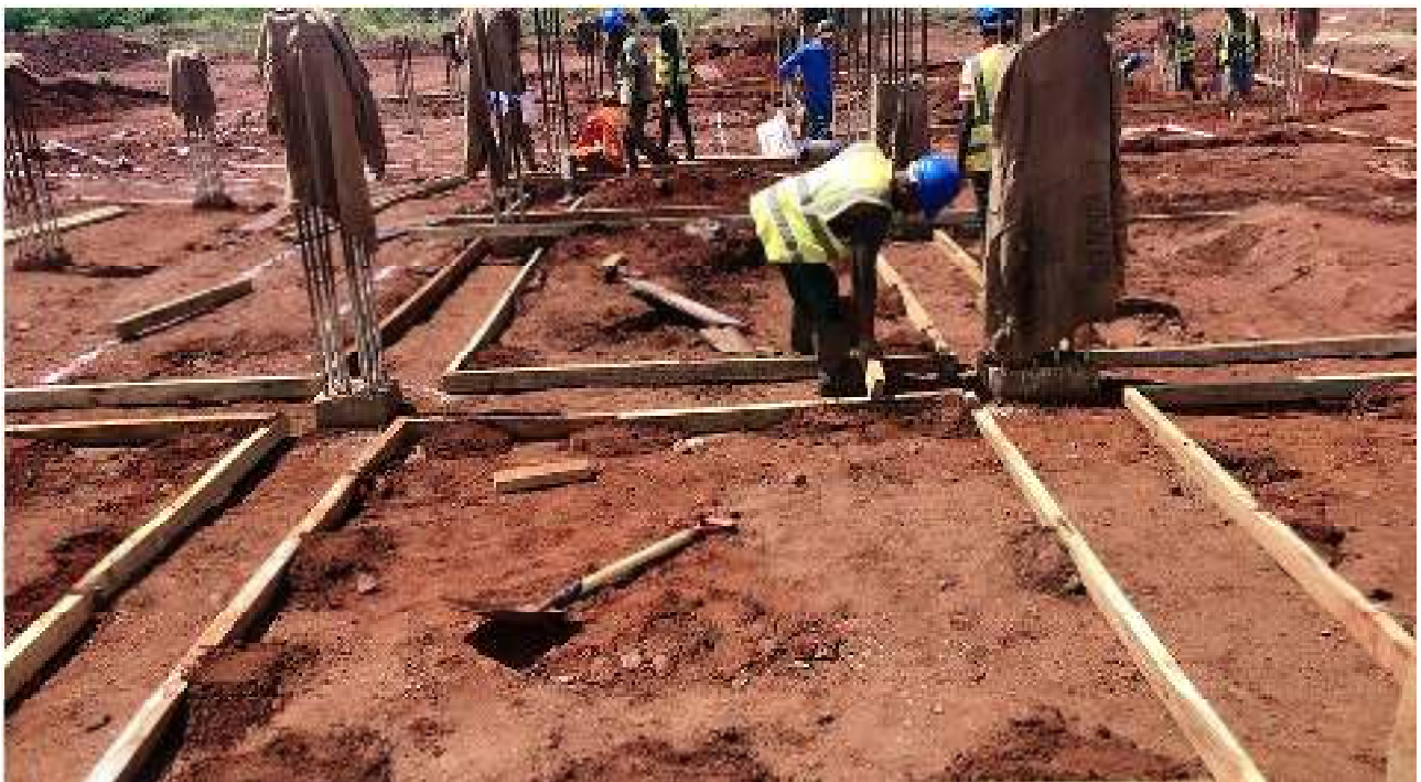
Picha inayoonesha ujenzi unaoendelea wa Jengo la “power house” katika uwanja wa Ndege wa Iringa.
