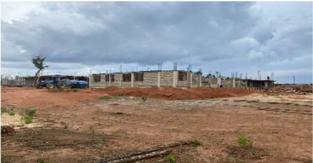
Picha inayoonesha hatua iliyofikiwa katika ujenzi wa Jengo la Utawala la Halmashauri ya Wilaya ya Iringa.
