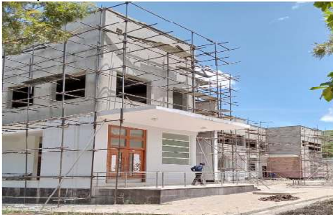
Picha inayoonesha muonekano wa nje wa jengo la Maabara ya Viumbehai linaloendelea kujengwa katika Chuo Kikuu Kishiriki cha Elimu Mkwawa
