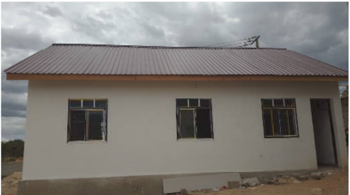
Picha inayoonesha ujenzi unaoendelea wa Jengo la Maabara katika Machinjio ya Kisasa ya Ngelewala iliyopo Halmashauri ya Manispaa ya Iringa.
