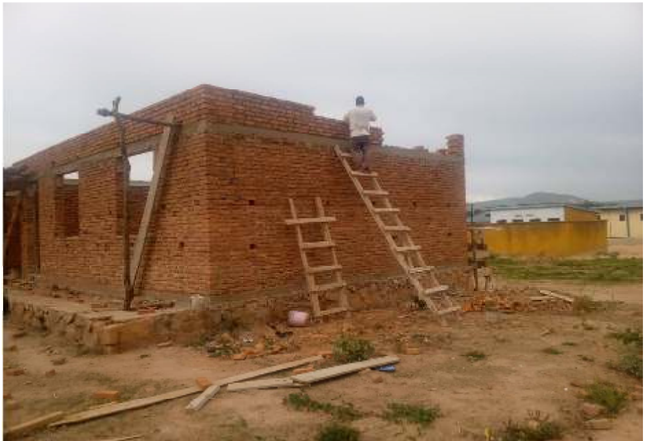
Picha inayoonesha kazi ya Umaliziaji wa ujenzi wa Madarasa mawili (2) Shule ya Sekondari ya Kalenga katika Halmashauri ya Wilaya ya Iringa.
